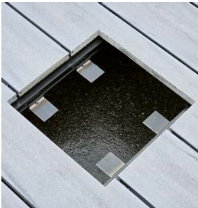
Windlastträger an der Alu-UK befestigen
