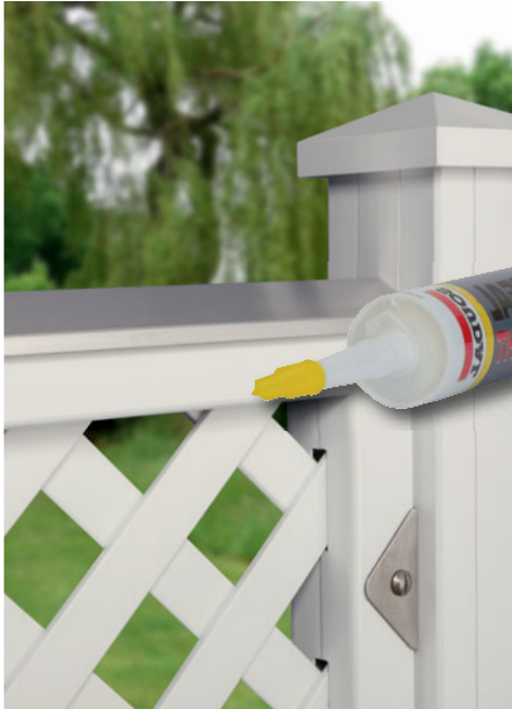
Designaufsatz Alu mit MS-Polymer-Kleber (1398) befestigen.
