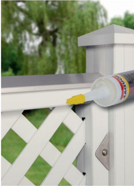
Designaufsatz Alu mit MS-Polymer-Kleber (1398) befestigen.
