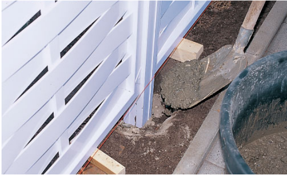
Zaunpfosten direkt ins Erdreich einbetonieren...
