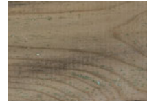
Umweltkeime, Stockflecken und leichter Schimmelbefall
