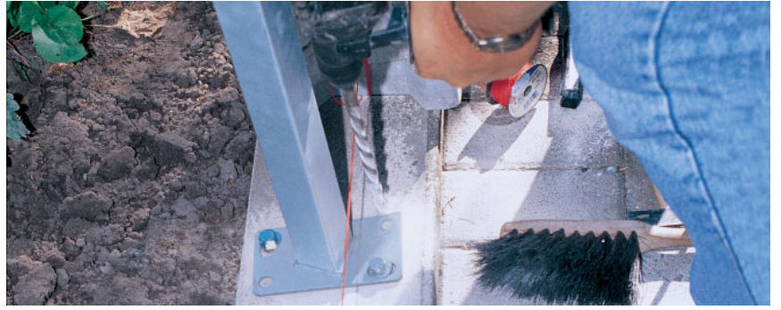
oder mit Pfostenträger aufschrauben.
